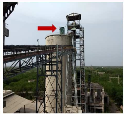
Fly Ash Silo
