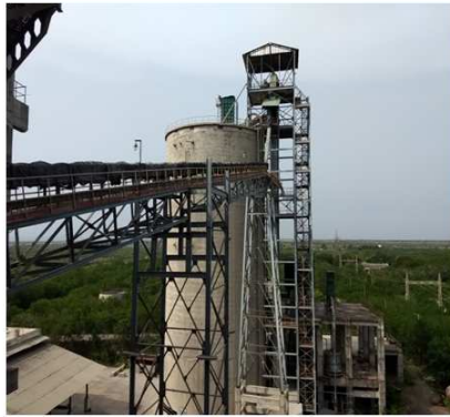
Fly Ash Silo
